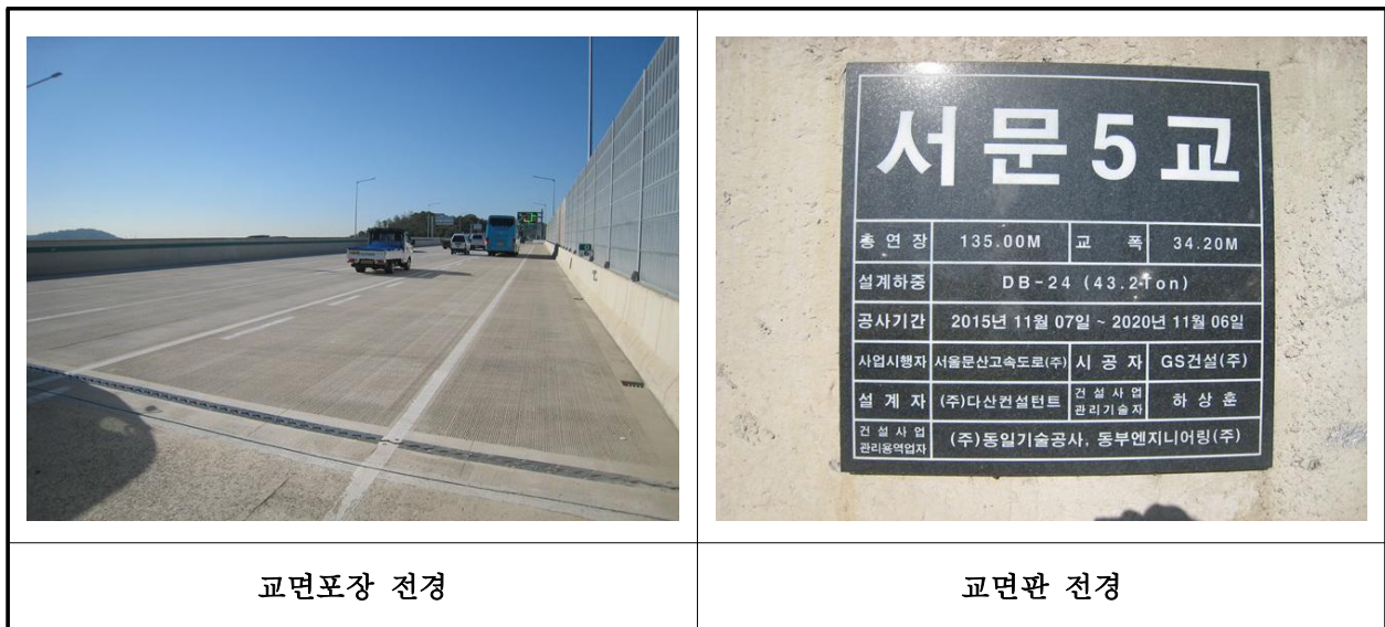
【사진 7.3.19】 교면포장 전경
