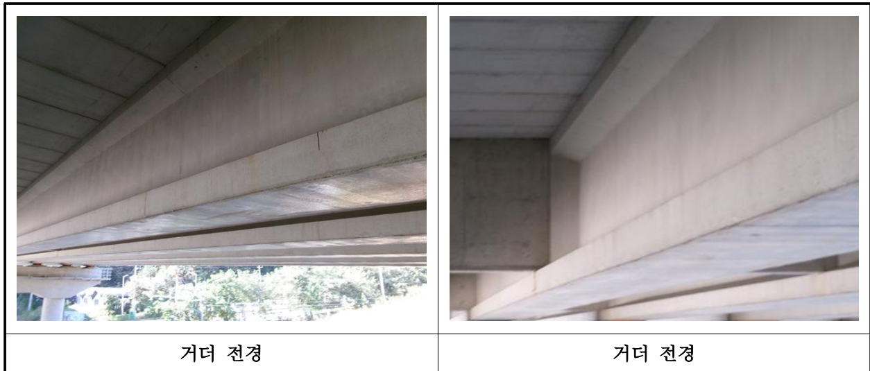
【사진 7.3.4】 거더 전경
