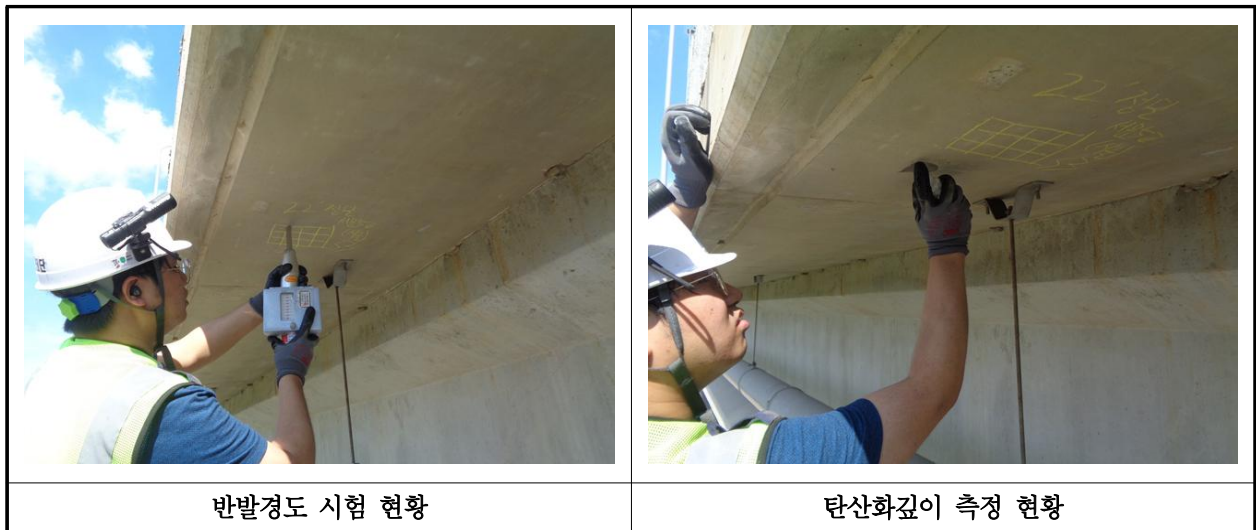
【사진 7.4.1】 콘크리트 내구성조사 현황
