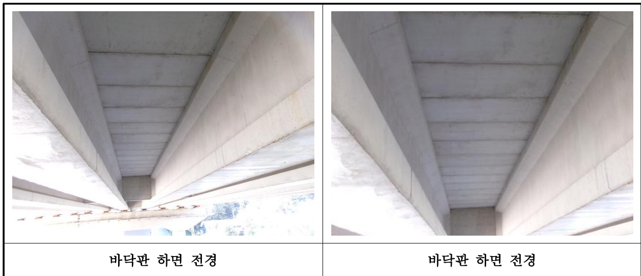
【사진 7.3.2】 바닥판하면 전경
