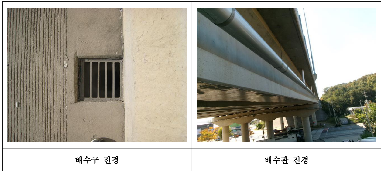
【사진 7.3.21】 배수시설 전경
