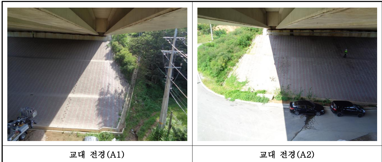
【사진 7.3.8】 교대 전경
