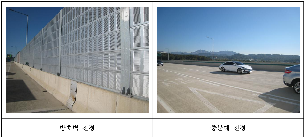
【사진 7.3.23】 방호벽 및 중앙분리대 전경
