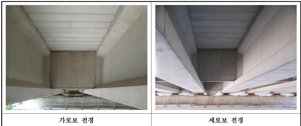
【사진 7.3.6】 가로보 및 세로보 전경
