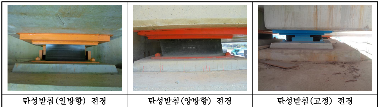
【사진 7.3.12】 교량받침 전경
