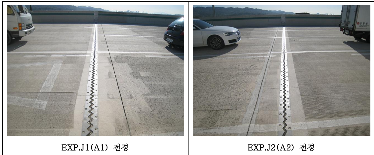
【사진 7.3.16】 신축이음장치 전경
